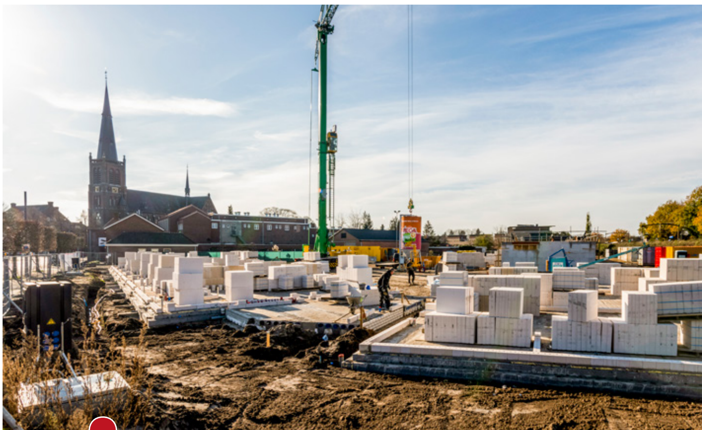
Voorstadhalte in Mierlo-Hout. Hier wordt een complex met veertig appartementen gebouwd.
